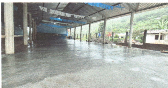
Foto 3: FUNDICION DE PISO DE CEMENTO EN SALON DE TIERRA.
