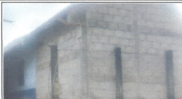
Foto 1: REMODELACION Y AMPLIACION DE COCINA
