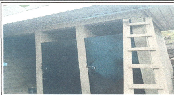
Foto 2: REMODELACION Y AMPLIACION DE BAÑOS
