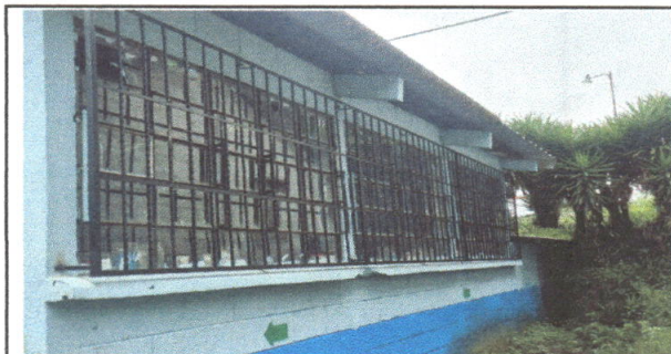
Foto 6: COLOCACION DE BALCONES.
