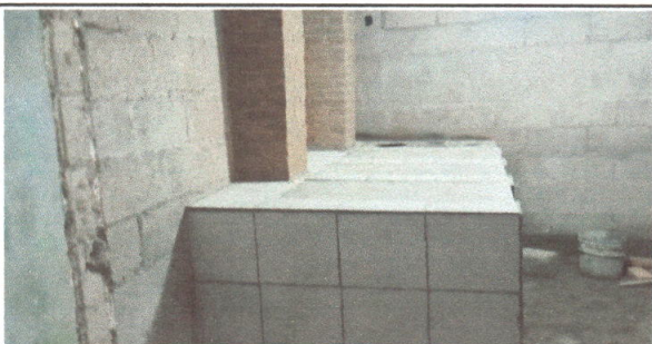
Foto 5: Remodelacion de polleto en cocina.
